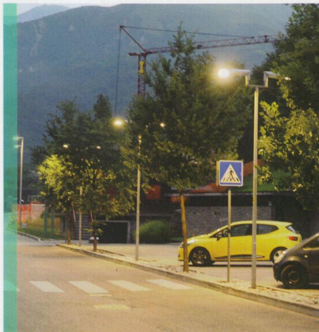
I lampioni Cree da 58 W LED montati a Fumone da Hera LUCE in luogo di quelli da 150 W.
