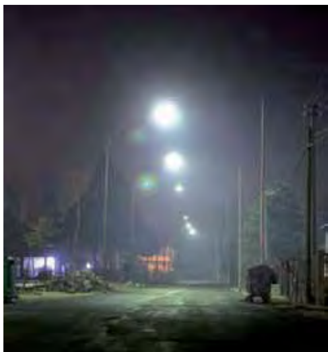
Lo stesso impianto con lampioni di vecchio tipo a vetro prismatico e lampade da 250 al mercurio 6 lux a terra
