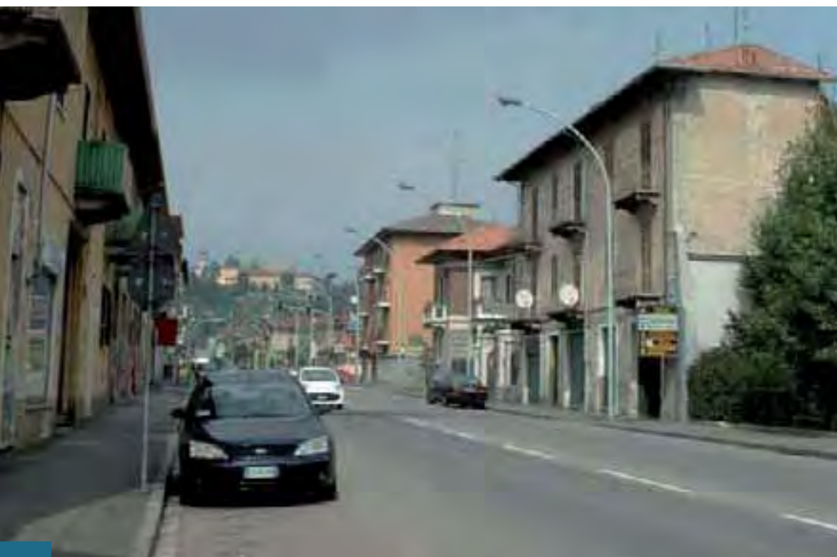
Caso, non raro, di erroneo posizionamento di lampioni a distanza inferiore del 50% a quanto previsto dal tipo di corpo illuminante
