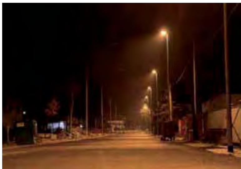
Nuovo impianto con lampade full cut-off da 150 w al sodio (via Fabi a Frosinone) 20 lux a terra
